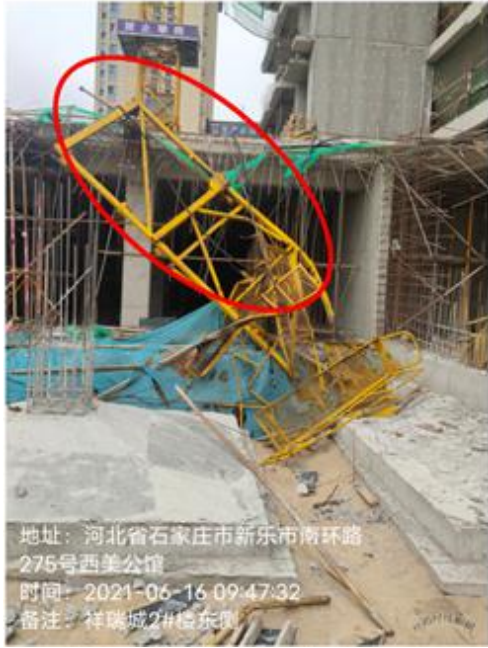
图3 解体的护套架
