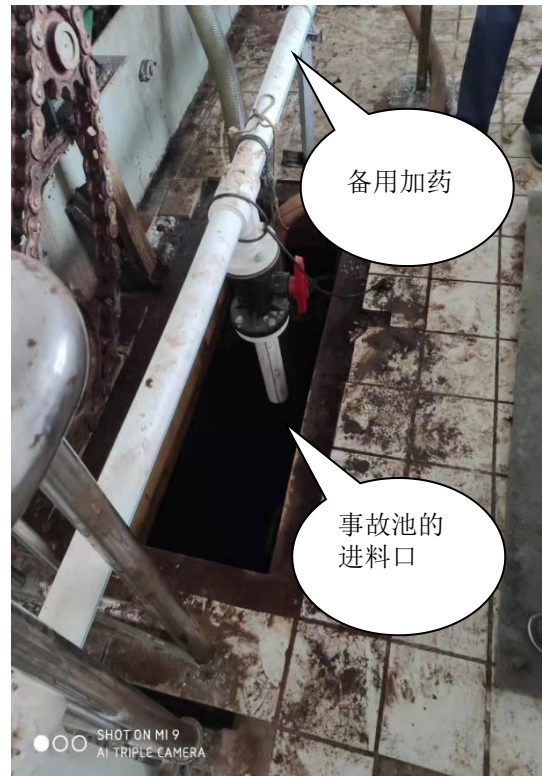
(下图为二期乙酸钠投加间加料口及卸料管图)
