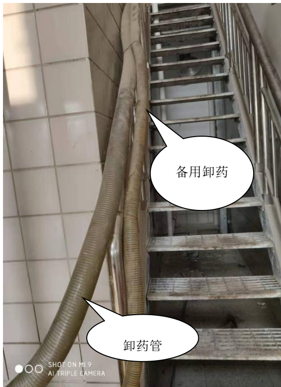
(下图为二期乙酸钠投加间加料口及卸料管图)
